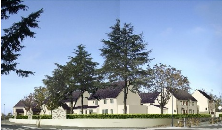
Visuel d'angles des 20 maisons en accession à la propriété (Bik architecture)
