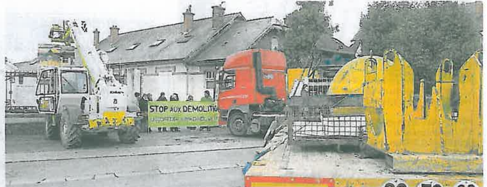
Trélazé, entrée de la Manufacture des Allumettes, hier matin. Une première fois refoulés en matinée, les camions transportant les engins de démolition sont entrés sur le site vers 14 heures, après le départ des manifestants.
