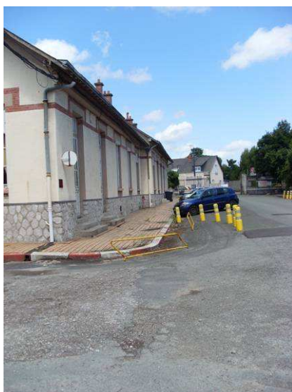
Entrée du site (vue depuis le fond du site)
