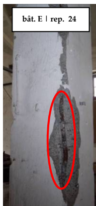
armature tordue cadres arrachés
