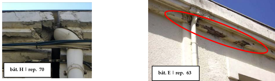
poutre extérieure support de chéneau fortement fissurée avec aciers apparents
