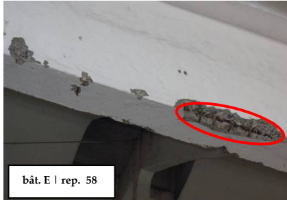
acier apparent suite à l'éclatement d'arrête
