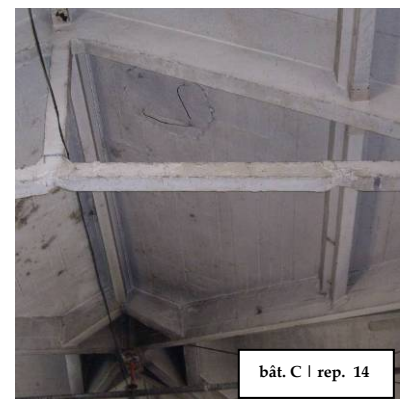
section d'entrail diminuer avec aciers apparents
